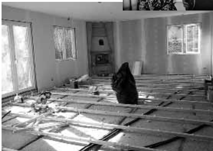
I ett Nivellgolv kommer inget organiskt material i kontakt med betongen. I stället vilar reglarna på plastkilar och under golvet skapas en två centimeter hög luftspalt.
