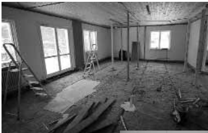
Innan det nya golvet byggdes gjorde man ordentligt rent och dammsög betongplattan.
